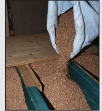
De vermalen natuurkurk wordt in de bouwsector gebruikt als isolatiemateriaal.
